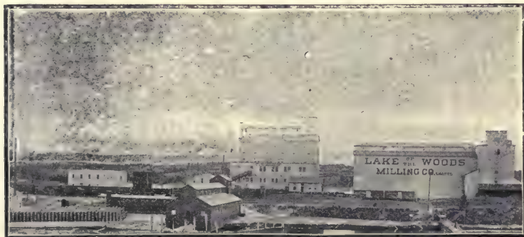
FIG. 62—Flour Milling Plant, Keewatin, Ont.
